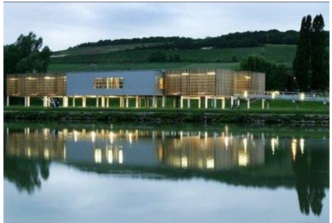
Gymnase nautique de Château-Thierry, Aisne, conçu sur pilotis afin de respecter les plus hautes crues connues de la Marne. Architecte Eric Pace.
