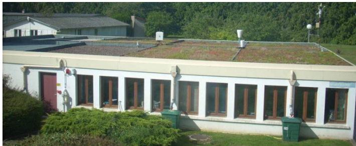
Toiture végétalisée du Centres d'Etudes Techniques de l'Équipement (CETE) Ile-de-France à Trappes.
